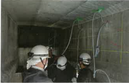
注入（既設桁再注入）
