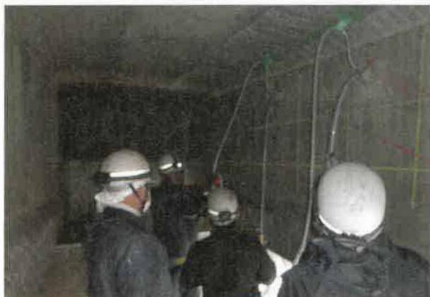
既設桁への再注入状況
