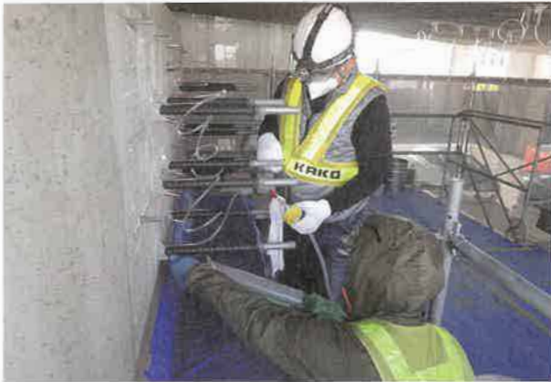
グラウト材注入状況
